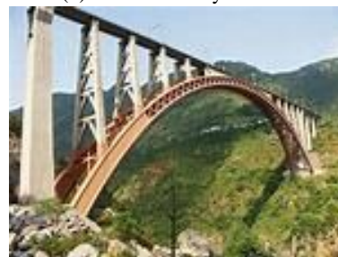
(d) Chenab Bridge
